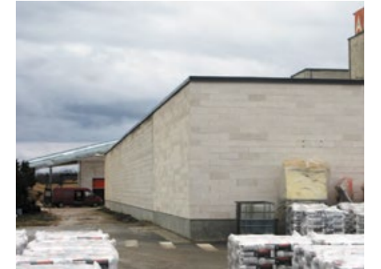
Рис. 4. Завод по производству автоклавного газобетона со стенами из неотделанной кладки, 2002 г.п., Эстония, волость Сымеру
