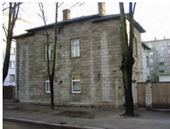
Рис. 1. Здание из автоклавного газобетона без наружной отделки. 1939 г.п., г. Рига, ул. Эльвирас, 15
