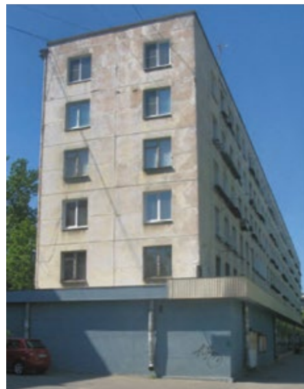
Рис. 2. Здание из автоклавного газобетона, 1960-е. Санкт-Петербург, Краснопутиловская ул., 45
