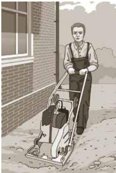
Качественное выполнение работ по подготовке основания на больших площадях может быть обеспечено при использовании автотракторной техники: бульдозер, грейдер, каток и пр.. Участки площадью до 100-150 кв.м, а также участки сложной формы, удобней готовить с помощью специального электро- и бензоинструмента (виброплита, виброрейка и пр.)
