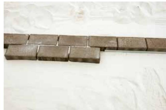
**6.** Обязательно качественное заполнение швов абсолютно сухим песком, либо послойное заполнение влажным песком с последующей проливкой за 2-3 раза. В процессе эксплуатации участка, в случае вымывания песка, производится просыпка швов.
