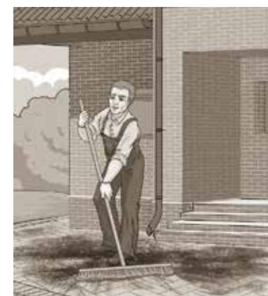
Швы финишно заполняются с помощью щетки. Для заполнения используют песок мелкой фракции (Мк<2,0). Пропилка швов способствует уплотнению песчаного заполнителя. Для заполнения швов можно использовать цветные смеси. Уплотнение облицовочного слоя производится при помощи виброплиты (m < 100 кг) с защитной плитой из неопрена.
