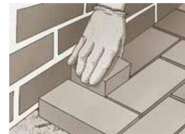
В местах примыкания мощения к границам площадки всегда остаются пустоты, меньше целого кирпича по размеру. Они заполняются доборными кирпичами, которые изготавливают при помощи отрезной пилы («болгарка») или циркулярная пила с диском для камня).
