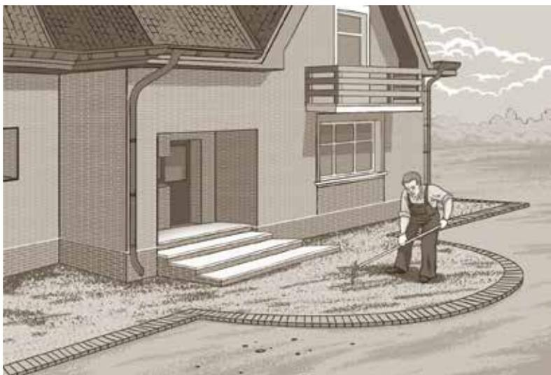
Подсыпка равномерно распределяется по поверхности несущего слоя и предварительно разравнивается с помощью подручного инструмента (например, граблей). Монтажный слой трамбуется (уплотняется) специальным электро- или бензоинструментом (виброплитой).
