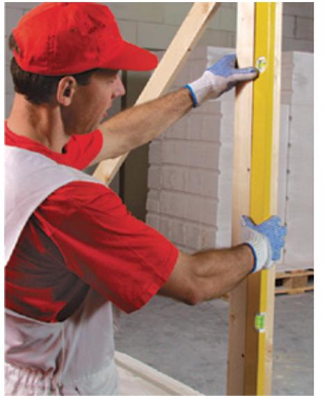
Установите рейки вертикально таким образом, чтобы четко обозначить ими углы кладки (рис. 5.23).
