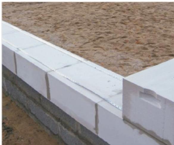
Каркасы для тонких швов можно заменить оцинкованной перфополосой, поставляемой на рынок в бухтах по 20–30 м. Минимальное сечение перфополосы  $15 \times 1$  мм. Полоса покрывается слоем kleя, не увеличивая общей толщины kleевого шва и не требуя трудоемкой операции по штраблению (рис. 5.22).
