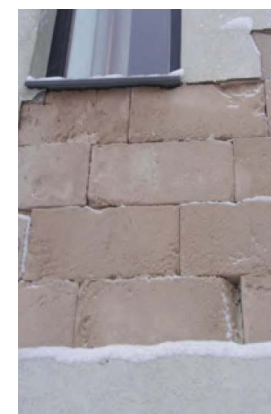
Рис. 16б. Отрыв штукатурки с высоким сопротивлением влагообмену от влажной кладки
