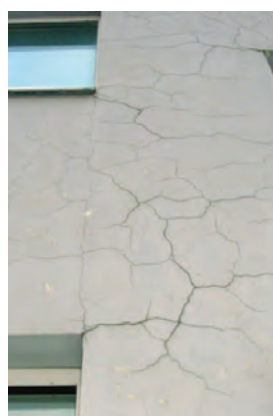
Рис. 16а. Трещины на штукатурке, затворенной избытком воды
