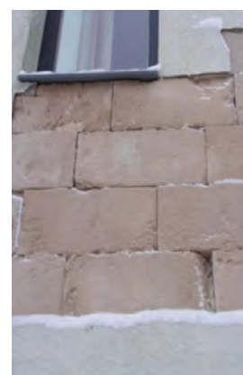
Рис. 16б. Отрыв штукатурки с высоким сопротивлением влагообмену от влажной кладки
