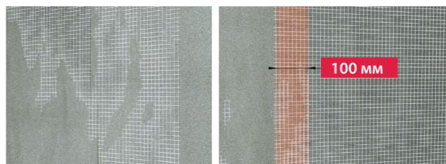
После приклеивания сетки нанести второй слой легкой смеси толщиной 3–5 мм, таким образом, чтобы сетка не просматривалась на поверхности, после чего окончательно выровнять поверхность. Общая толщина базового штукатурного слоя должна составлять 6–10 мм.
