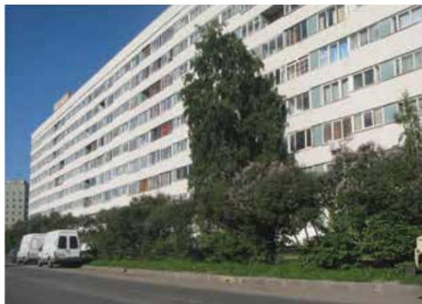
Рис. 3. Наружные стены из автоклавного газобетона. «Корабль», 1970-е, Санкт-Петербург
