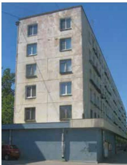
Рис. 2. Здание из автоклавного газобетона,
