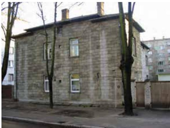
Рис. 1. Здание из автоклавного газобетона без наружной отделки.
