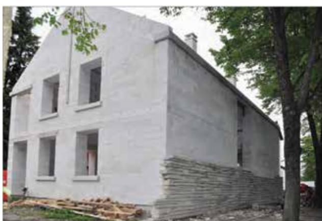
Контактная зона между наклеенной плиткой и стеной в морозном климате постепенно теряет прочность, поэтому полезно армировать клеевой слой сетками – местное нарушение сцепления клея со стеной в этом случае не приведет к выпадению плиток с ее поверхности.
