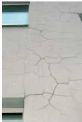
Рис. 16а. Трещины на штукатурке, затворенной избытком воды
