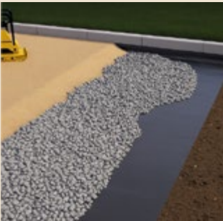
4. Устройство несущего слоя из щебня
