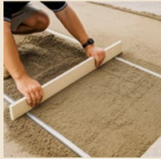
3. Устройство выравнивающего песчаного слоя
