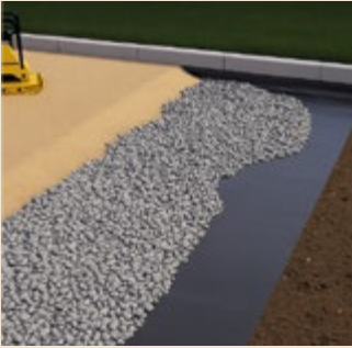
4. Устройство несущего слоя из щебня
