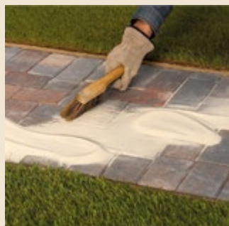
8. Заполнение швов материалами с высокой водопроницаемостью: Tubag PFL (Quick-Mix), или чистый кварцевый песок фракции 0-2 мм
