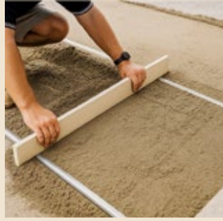
3. Устройство выравнивающего песчаного слоя
